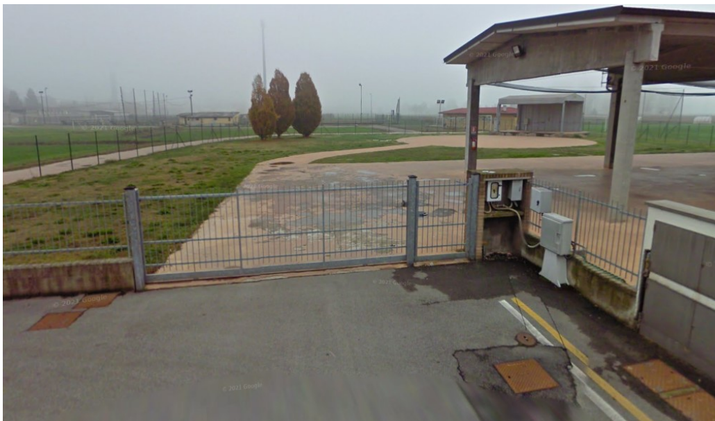
Ingresso carraio e pedonale esistenti
